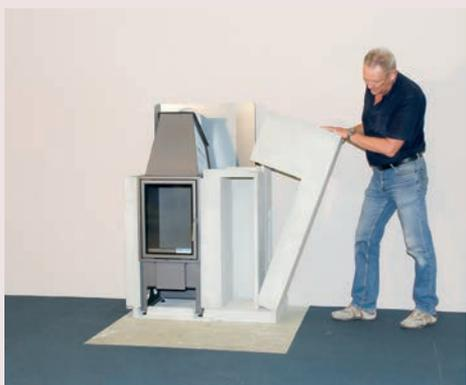
Assembler et coller les éléments d'habillage pièce par pièce
