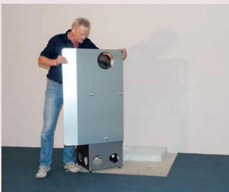
Monter la plaque de protection thermique (accessoire)
